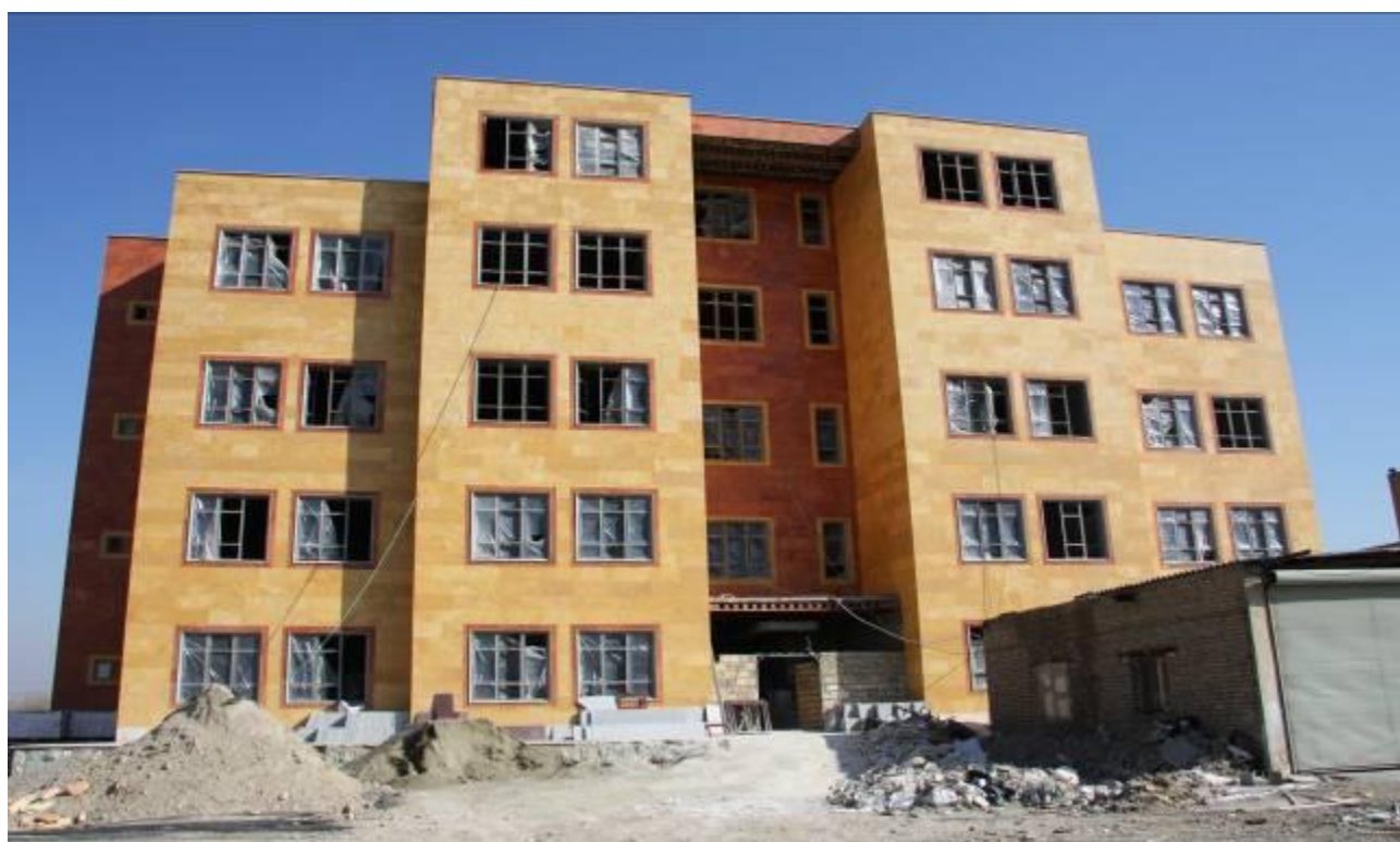
و در حال حاضر ساختمانهای به شرح زیر در دست احداث می باشد. ۱- ساختمان آزمایشگاه در ۵ طبقه به مساحت ۳۶۷۴/۵ مترمربع
