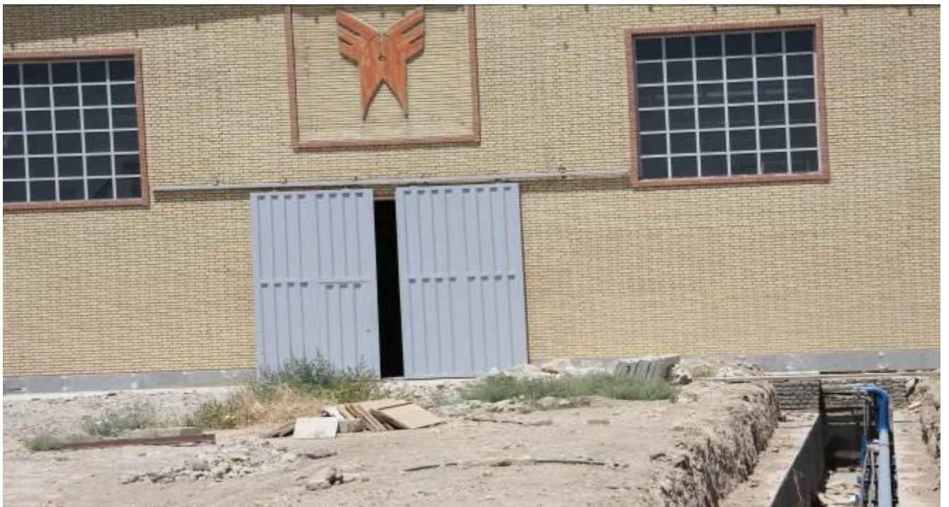
۱۴- کارگاه مکانیک به مساحت ۵۹۰ مترمربع
